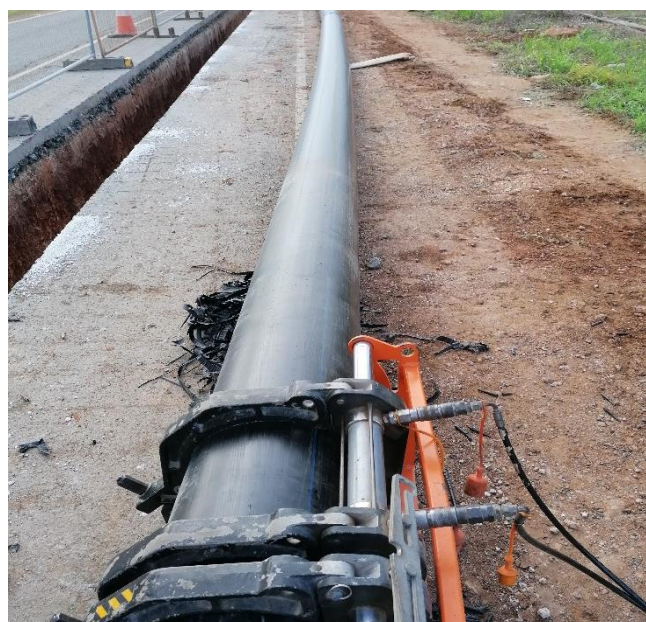
Εγκατάσταση αγωγού άντλησης για τη μεταφορά λυμάτων από την Κοινότητα Φρενάρους προς την Κοινότητα της Αυγόρου | Installation of forcemain for the transport of sewage from the Community of Frenaros to the Community of Avgorou.
