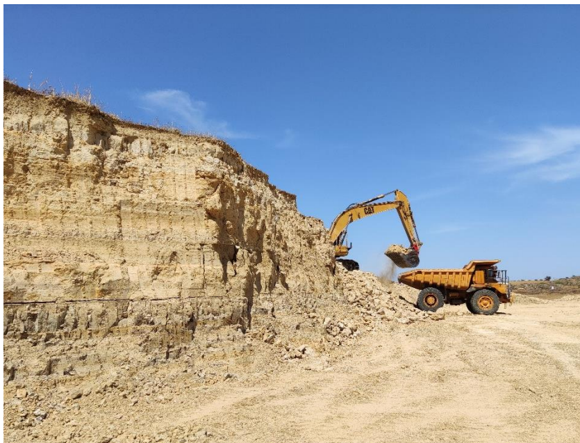
Χωματοургικές εργασίες για τη διαμόρφωση των δεξαμενών μακροπρόθεσμης αποθήκευσης ανακυκλωμένου νερού | Earthworks for the formation of the long-term storage ponds.
